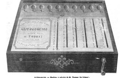
Arithmometre. — Machine à calculer de M. Thomas (de Colmar).
