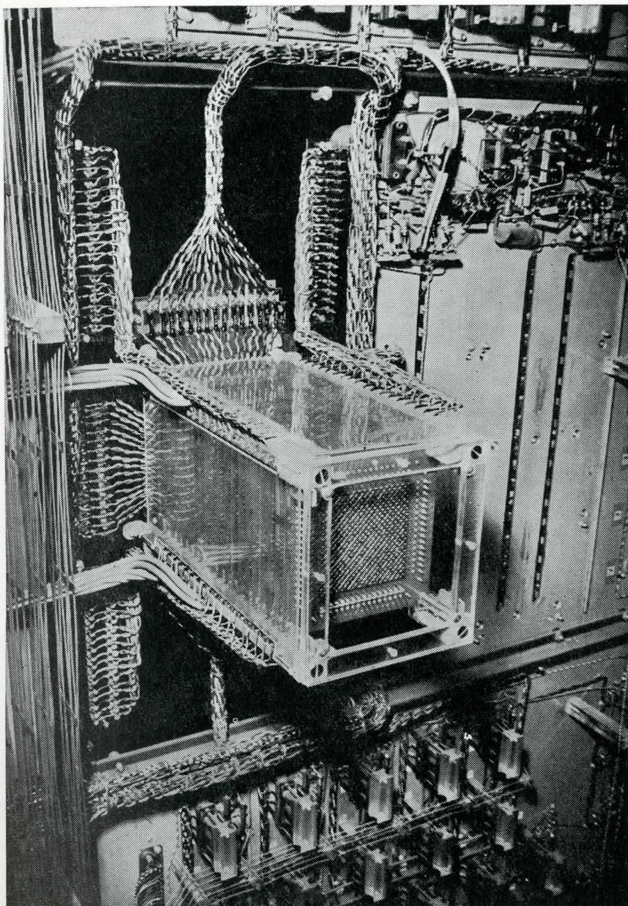
Fig. 3 - La memoria a nuclei magnetici della «Macchina Ridotta»
