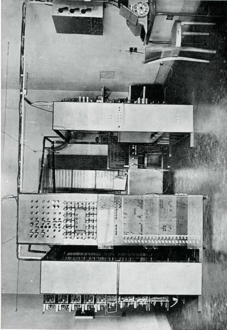
Fig. 1 - Vista generale dell'impianto della « Macchina Ridolfi »
